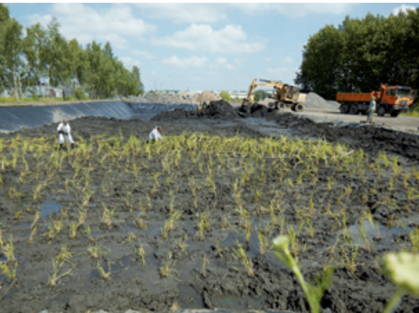
Abb. 12: Behandlung schwermetallhaltiger Sedimente durch Phytoremediation
